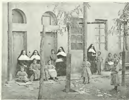
COUR INTÉRIEURE DE L'ÉCOLE DES SOEURS, A CÉSARIE
